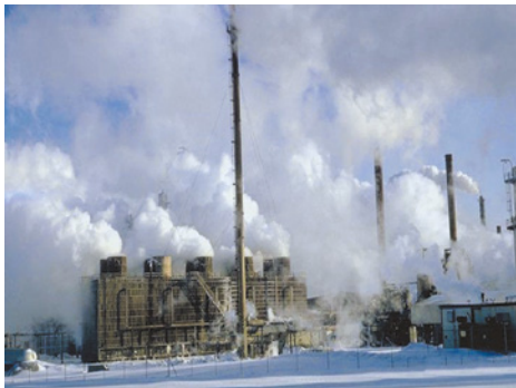
Рис. 182. Химически опасный объект
