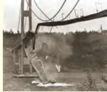
Рис. 29. Разрушенный мост через реку Такома (США)
