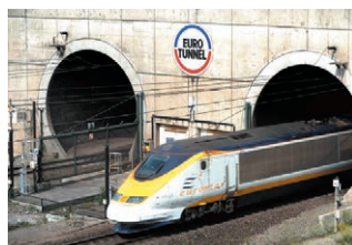
L'Eurotunnel sous la Manche
