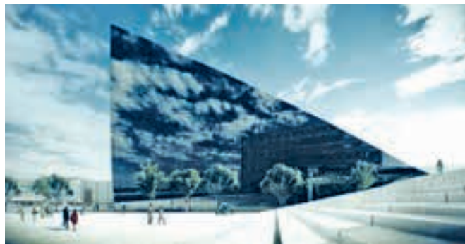
Мал. 170. Энергазберагальны будынак у Тронхейме
