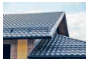
Палімернае пакрыццё на металічнай чарапіцы
