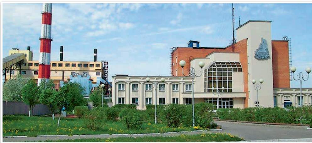
Аршанская ГРЭС — першая беларуская электрастанцыя. Сучасны выгляд
