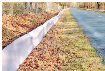
Мал. 127. Загараджальныя збудаванні: а) каля аўтамабільнай дарогі; б) тунэль для жаб
