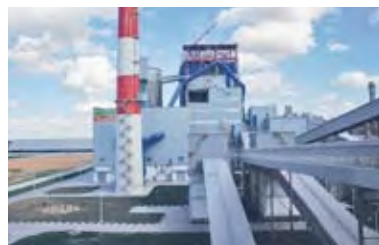
Рис. 149. Белорусский цементный завод, г. Костюковичи
